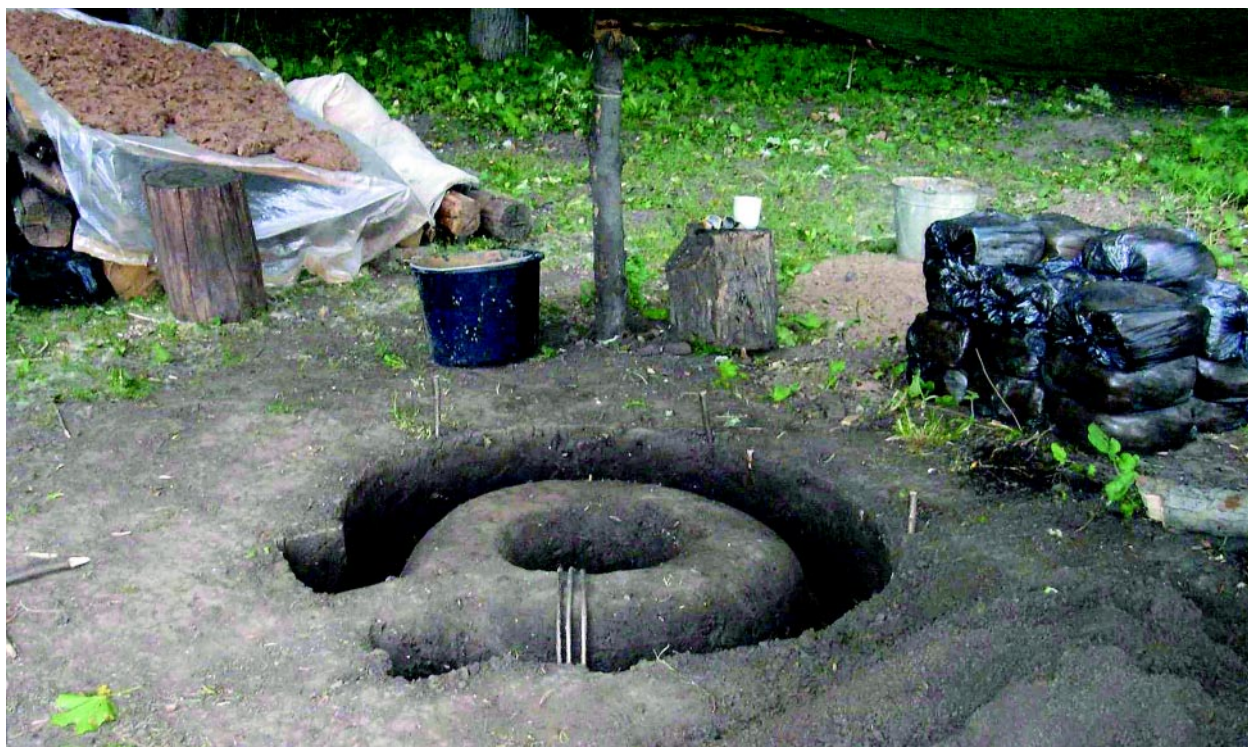
Рис. 2. Шаблон в грунте для формовки топочной камеры гончарного горна
