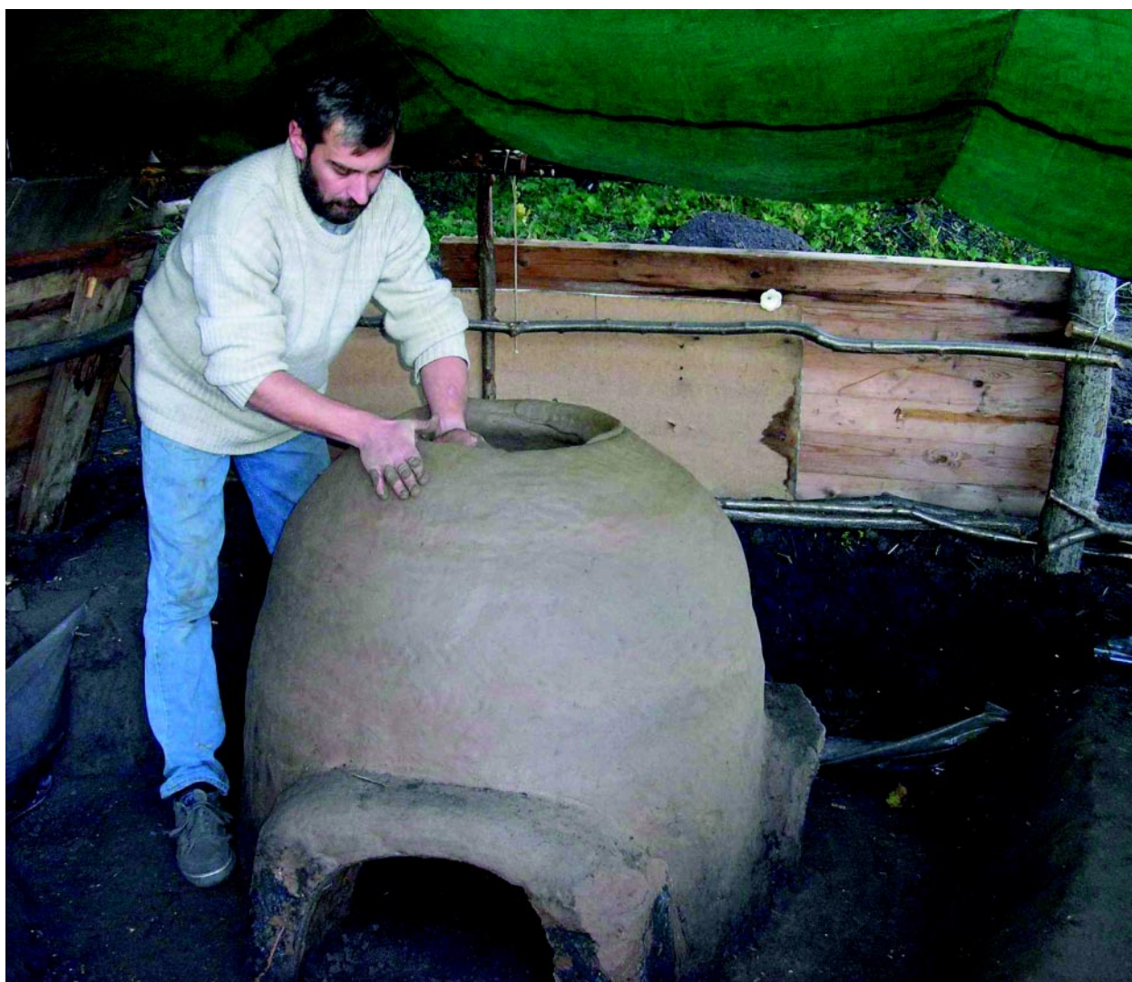
Рис. 3. Формовка жгутовым налепом купола обжиговой камеры
