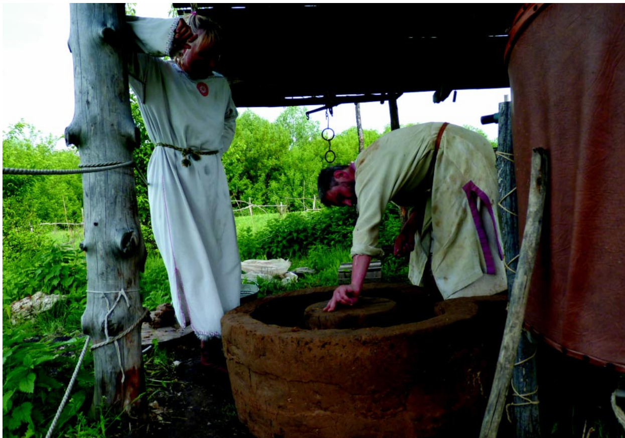
Рис. 7. Гончарная мастерская Центра, строительство гончарного горна.
