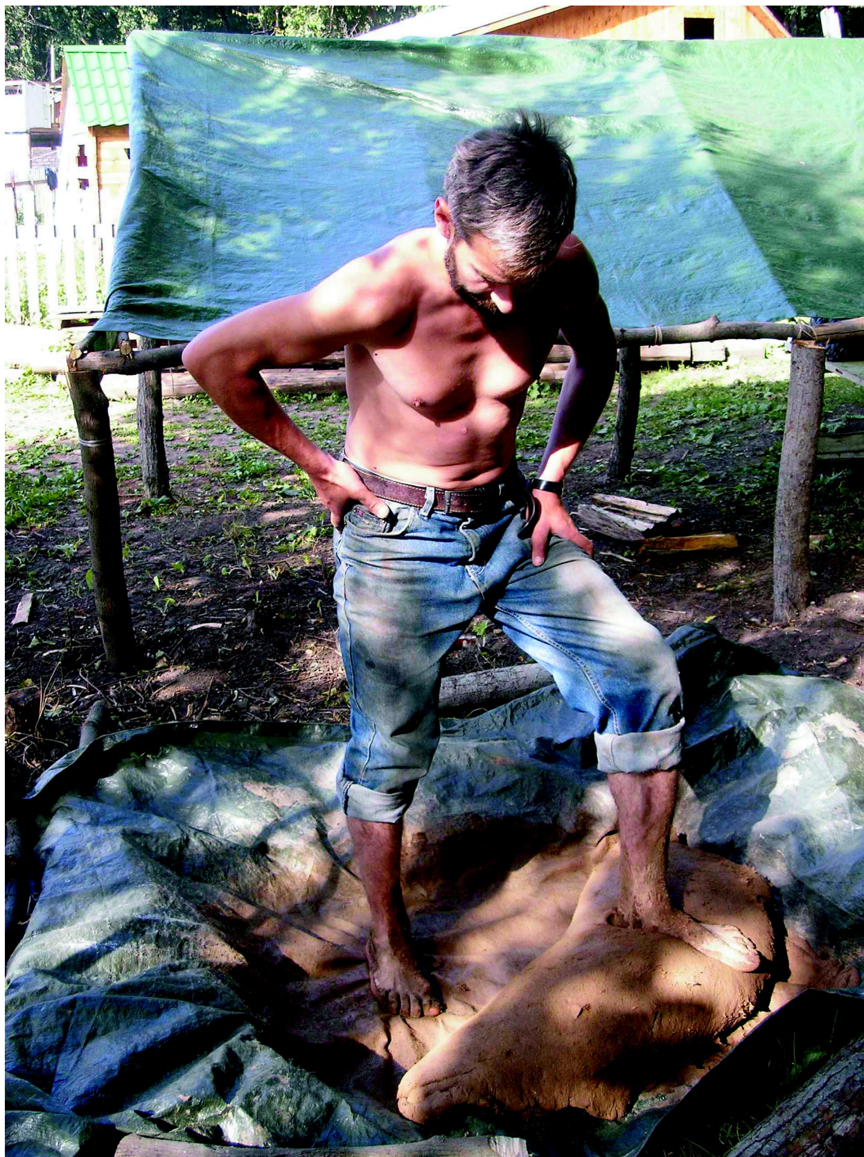
Рис. 1. Подготовка формовочной массы для строительства гончарного горна
