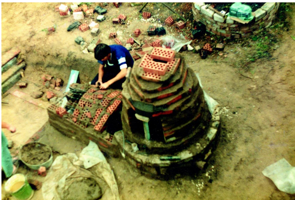
Илл. 5. 3–4. Эксперимент по обжигу глиняной посуды в Самарской экспедиции по экспериментальному изучению древнего гончарства. строительство кирпичного наземного горна (2000 г.). 3 — сооружение топочного канала; 4 — строительство арочного перекрытия над топочным каналом.
